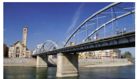
Pont de l'Estat sobre el riu Ebre, a Tortosa.
