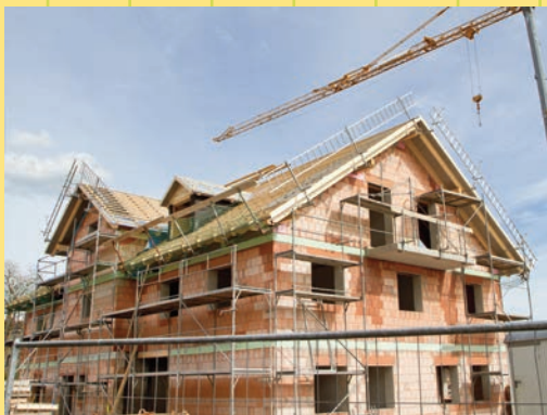
Bastides per a la construcció.
