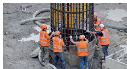
Estaques. Són l'equivalent d'una columna enterrada. Es construeixen omplint de formigó armat forats cilíndrics. S'acostumen a utilitzar per donar estabilitat a grans infraestructures.
