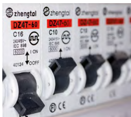
Interruptor automàtic típic de les instal·lacions elèctriques dels habitatges.
