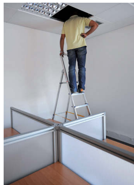
La construcció de falsos sostres és habitual en els blocs de pisos i permet accedir fàcilment a les instal·lacions.
