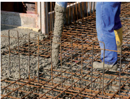
Forjat amb formigó armat.
